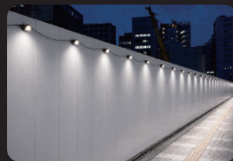
平面の仮囲い照明
