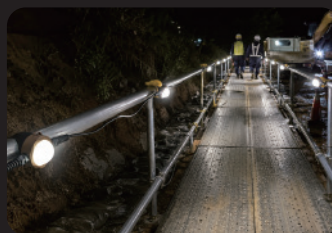
夜間復旧工事 仮設通路
