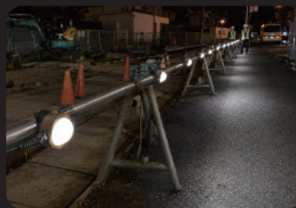
夜間工事 仮設安全照明
