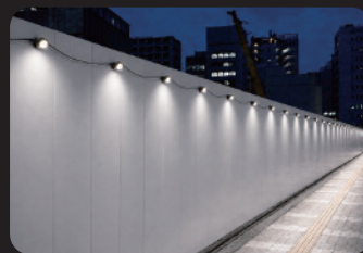
平面の仮囲い照明
