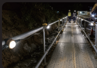
夜間復旧工事 仮設通路
