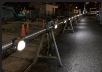
夜間工事 仮設安全照明
